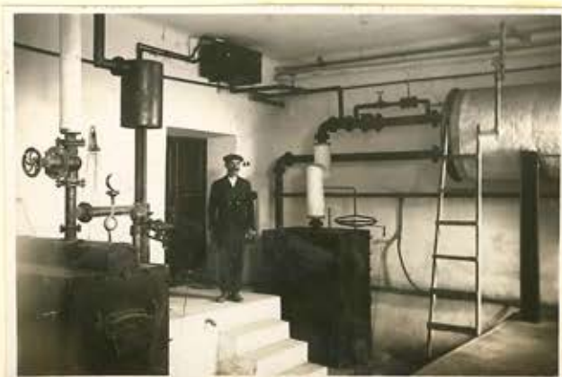
Kotłownia - pałacu M. Ciechaniewicza.
