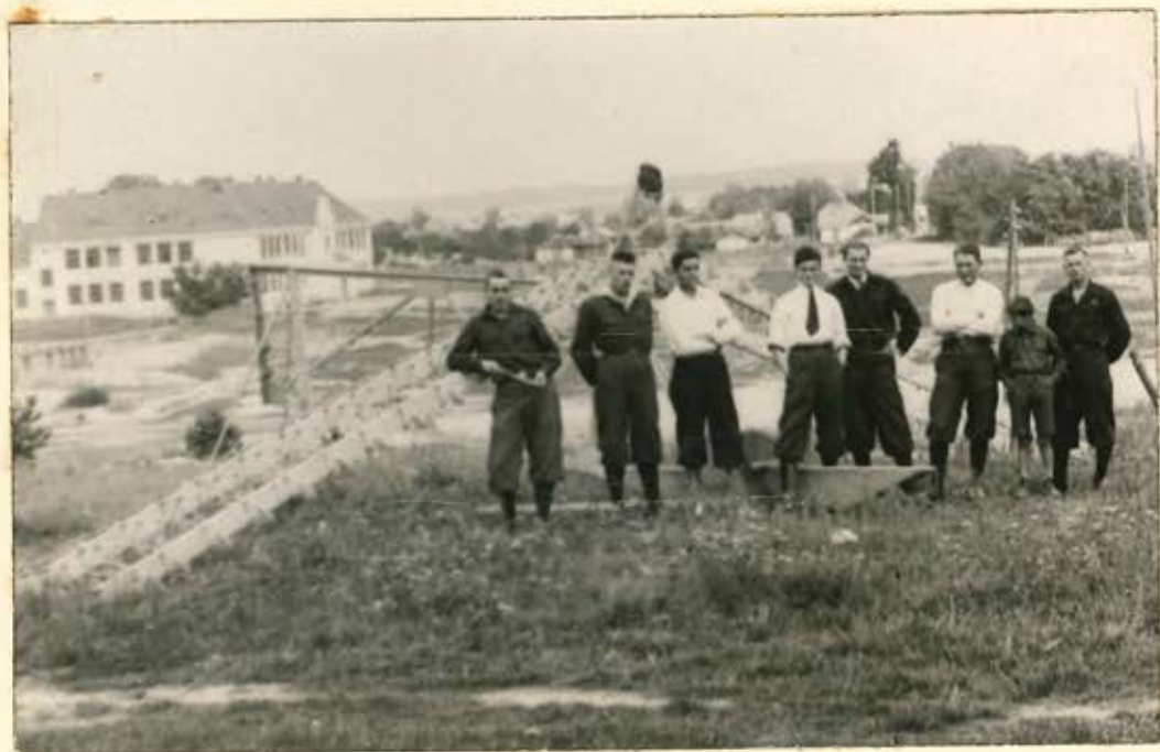
Prace murników około wykończenia srybowca w r. sek. 1930/31.
