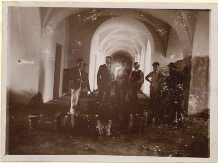
Układanie posadzki linotolowej i korytarzu parteru w sierpniu 1929 r.
